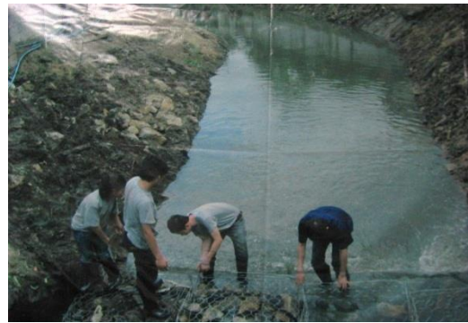
図4 金網に石を詰めた蛇籠堰の設置
