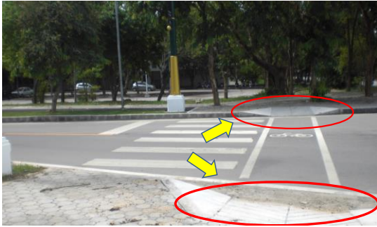
Fig. 4 歩道・自転車道から本道への段差解消
