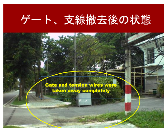
Fig. 3 ゲートと支線撤去後の状況
