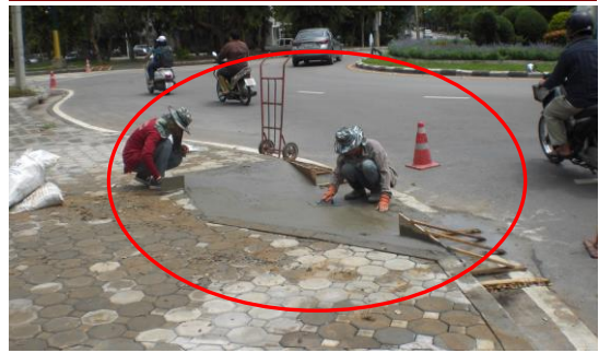
Fig. 5 縁石を一部撤去しての段差解消工事
