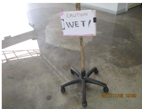
Fig. 2 雨の吹き込みで床の濡れに注意を 促す立て掛け警報ビラ
