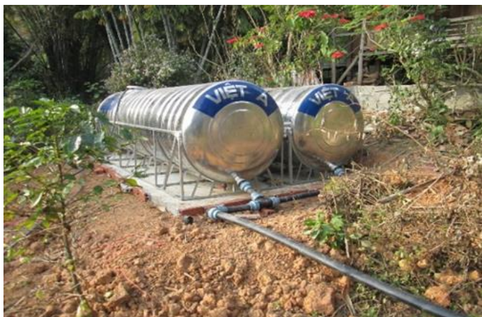
写真4：貯水タンクの設置
