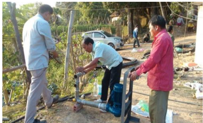
写真2：灌漑用ポンプの設置
