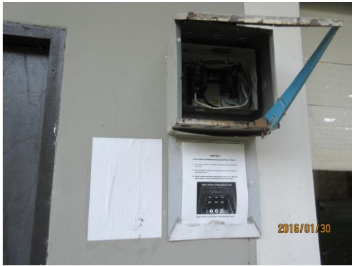
図1 籠球コートの照明スイッチ操作説明
