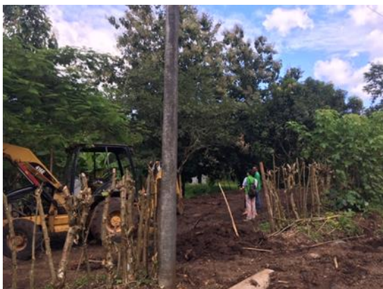
写真 13. 油圧ショベルにての作業
