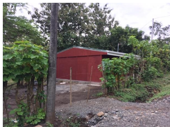
写真 14. 新築建設風景
