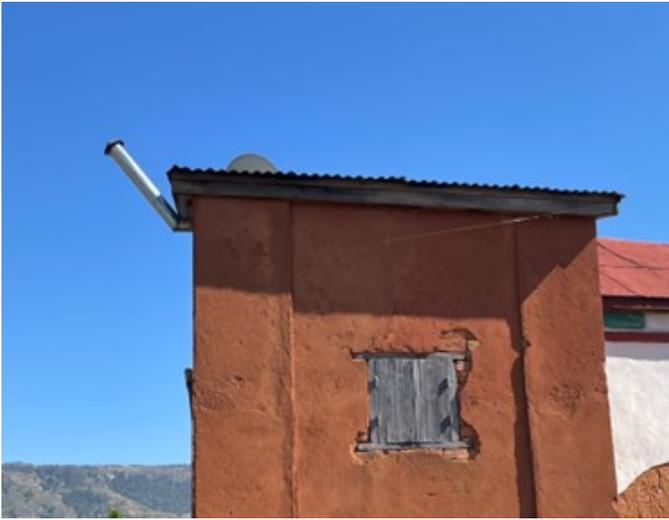
写真：台所に煙突が設置されているが、機能しておらずに調理時は煙たくなる。
