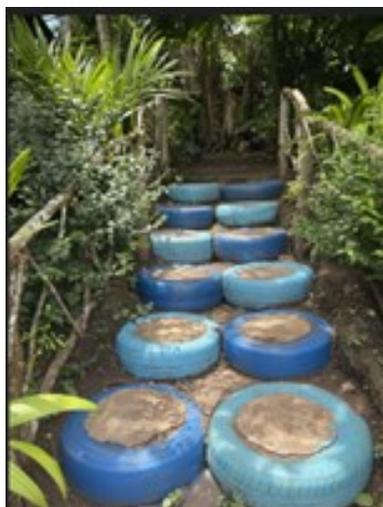
写真：滑らないようにと手作りの玄関アプローチ：タイヤの階段と木の手すり
