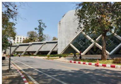
図2 工学部の中心的、象徴的建物
