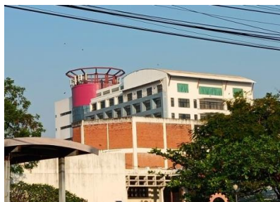
図8 前の写真のクローズアップ（屋上にある皿状の構造物が象徴的目安）。
