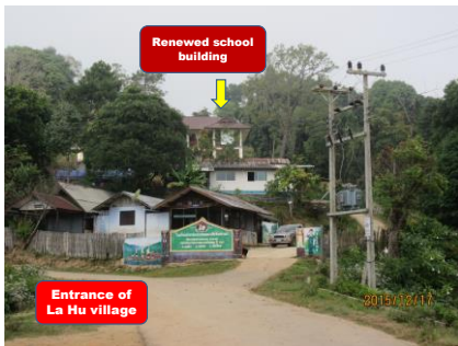
図9 ファン地区ラフー族村落の入り口。後方にEITの協力で新築した鉄筋コンクリートの校舎が見える。
